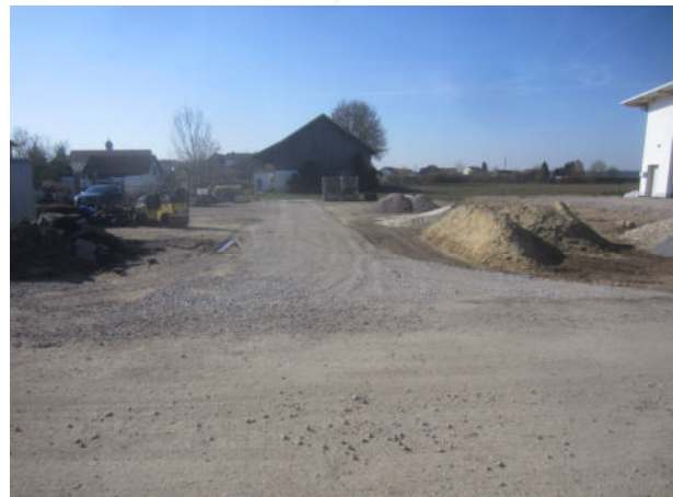
Abb. 11: Blick vom Hainbacher Weg nach Süden auf die vorh. landw. Gebäude; rechts Biomasse-Heizw.
