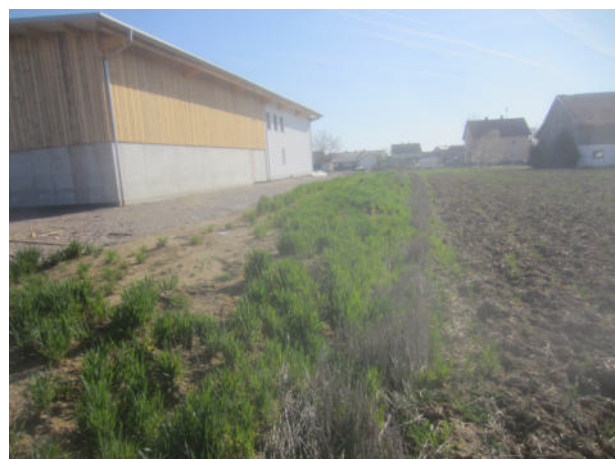
Abb. 13: Blick südl. Biomasse - Heizwerk nach Osten zu den abzureissenden Gebäuden
